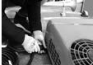
PASSO 4 - Conexão do cabo de alimentação na caixa.
