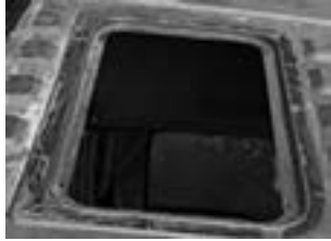
PASSO 1 - Remoção da claraboia.
