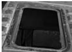
PASO 1 - Desmontaje de la claraboya.
