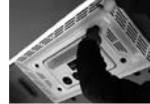
PASSO 7 - Aplicação dos tampões.
