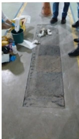
Reparo da área
